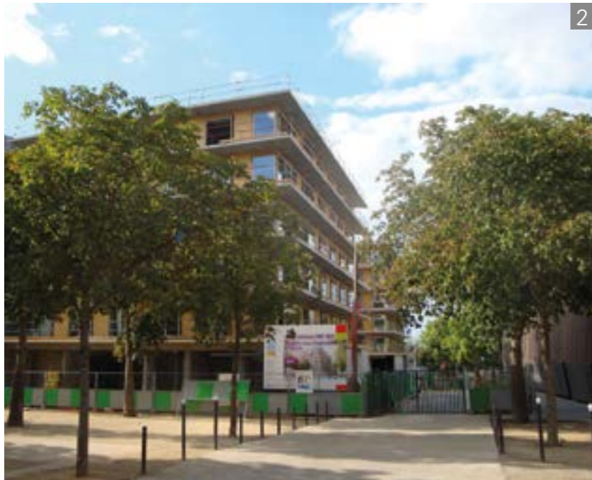
2. Paris: Wohnhäuser an der Porte de Monmartre, im Bau (2012–2016). | Paris: Residential buildings under construction in Porte de Monmartre (2012–2016).
