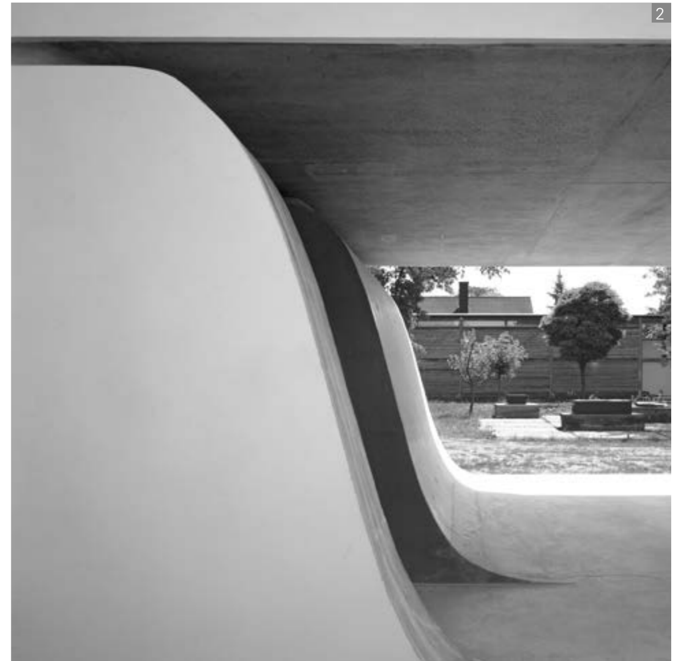
2. Licht und konstruktive Fügung: Dem Bildhauer Karl Prantl und seine Frau lieferte Roth einen 25 Meter langen, schwebenden Schrein und damit den Nachweis darüber, was heute ein „Künstler-Architekt“ leisten kann. | Light and constructive foreordination: Roth provided the sculptor Karl Prantl and his wife with a 25 metres long hovering shrine and therefore proof of what an "artist architect" can do today.
